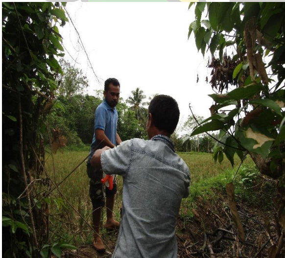
Proses pengukuran Tanah untuk pembangunan Irigasi Gampong Cureh
