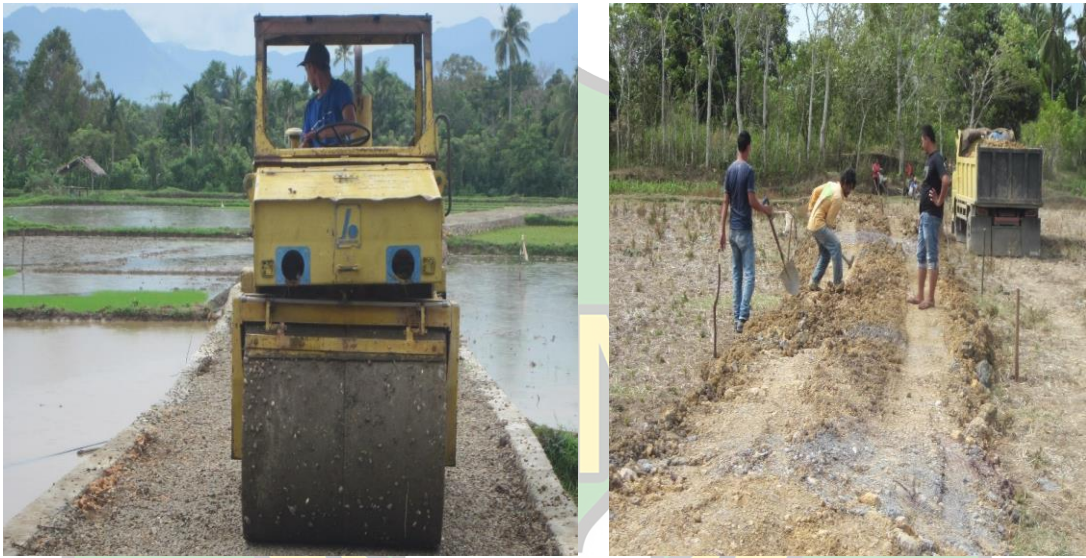
Proses pembangunan jalan penghubung antar sawah di Gampong Cureh
