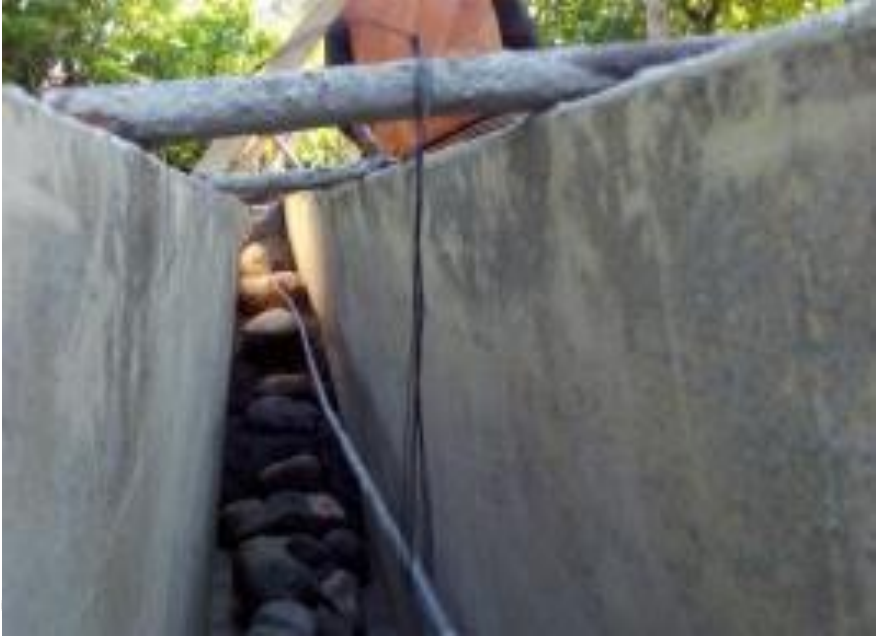
Gambar: Pembetonan parit-parit di Gampong Durian Kawan
