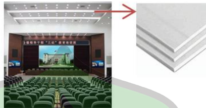
Gambar 5.8: Plafond Gypsum di Auditorium (Sumber: Analisa Pribadi)
