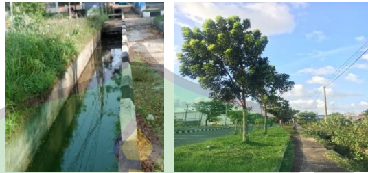
Gambar 4.4: Utilitas di Lokasi Perancangan (Sumber: Dokumentasi Pribadi)
