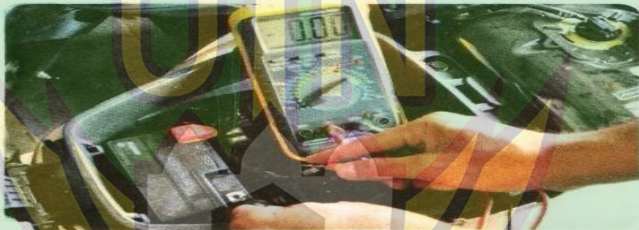
Ukur kebocoran arus dilakukan secara seri antara kutup negati baterai dengan klem terminal kabel negatif Hasil standar tidak boleh lebih dari 0,01 mA
