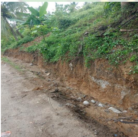
Gorong-gorong yang dibangun di samping lintasan Kecamatan Juli sebagai bentuk penanggulangan banjir yang tidak bersihkan dan tidak dilakukan pengerukan tanah
