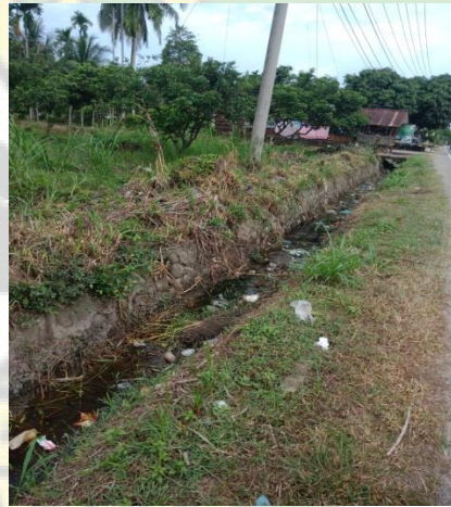
Gorong-gorong yang dibangun di samping lintasan Kecamatan Juli sebagai bentuk penanggulangan banjir yang tidak bersihkan dan tidak dilakukan pengerukan tanah
