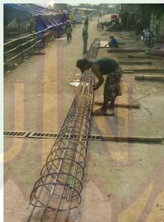
Gambar 4.59 : Kolom menggunakan pengikat spiral
