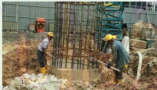
Gambar 4.54 : Bore Pile
