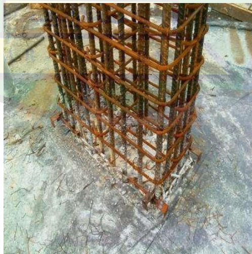
Gambar 4.58 : Kolom menggunakan pengikat sengkang lateral
