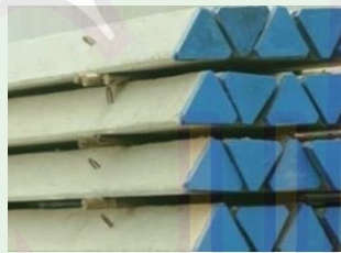
Gambar 4.50 : Minipile bentuk penampang segitiga
