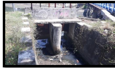
Gambar 4.9 pintu air Sumber: dokumnetasi pribadi, 2018
