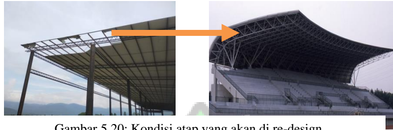
Gambar 5.20: Kondisi atap yang akan di re-design Sumber : Dokumen pribadi/google.com
