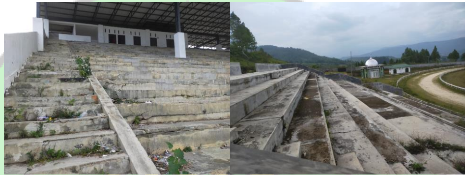
Gambar 4.2: Lantai Eksisting Sumber : Analisa Pribadi
