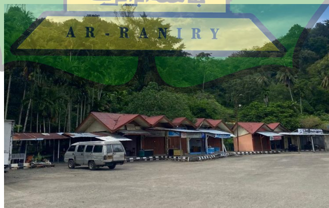
Gambar 4.2.1.2 Kondisi Ruko Terminal Sumber: Dokumentasi Lapangan oleh peneliti, 2024
