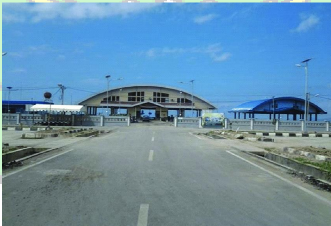
Gambar 2. Pelabuhan Perikanan Samudera / TPI Lampulo
