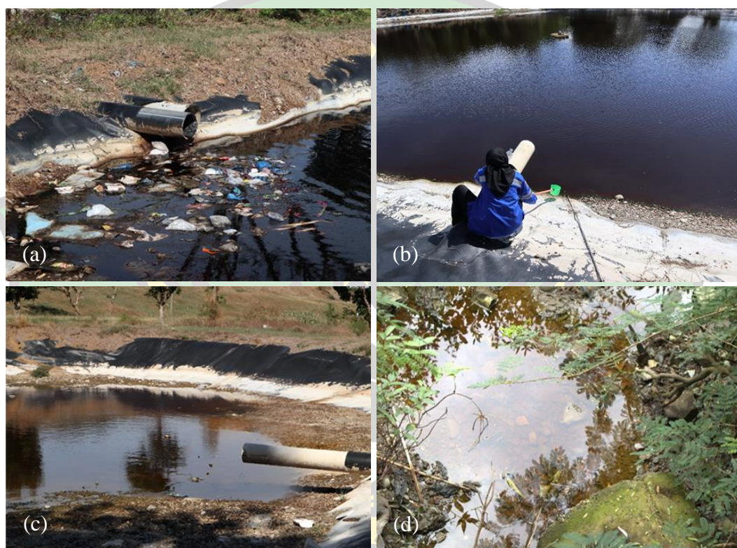
Gambar 3.2 (a) Kolam Anaerob; (2) Kolam Fakultatif; (3) Kolam Maturasi; dan 4) Efluen Air Lindi
