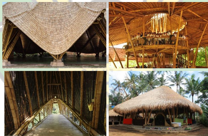
Gambar 2. 43 Material utama bambu pada Green School Bali
