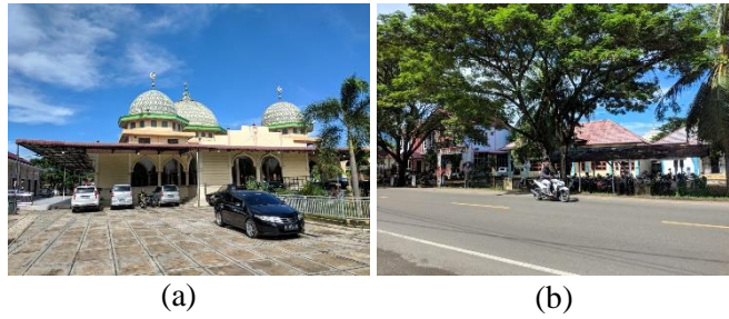
Gambar 2. 31 (a) Masjid Jami' Sibreh, (b) Area Perkantoran (Sumber: Dokumentasi Pribadi, 2021)
