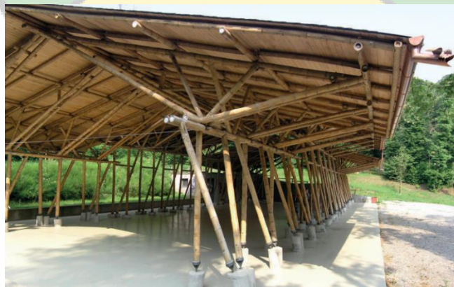
Gambar 4. 41 Kolom dari bambu
