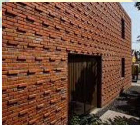
Gambar 4. 45 Dinding dengan material bata
