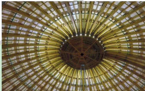
Gambar 4. 43 Rangka Atap dari bambu
