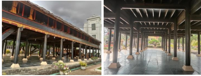
Gambar 4.5 Fasad Rumoh Aceh
