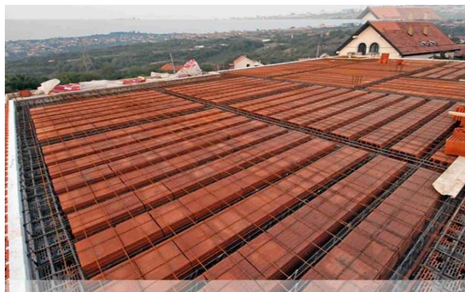
Gambar 5.10 Struktur Atap Dak
