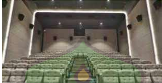
Gambar 5. 26 Perangkat Audio di Dinding Bioskop
