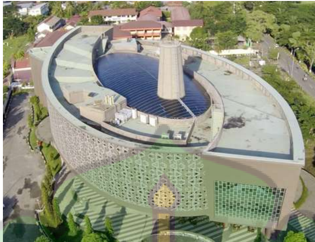
Gambar 3. 8 Rooftop yang Menjadi Fungsi Survive
