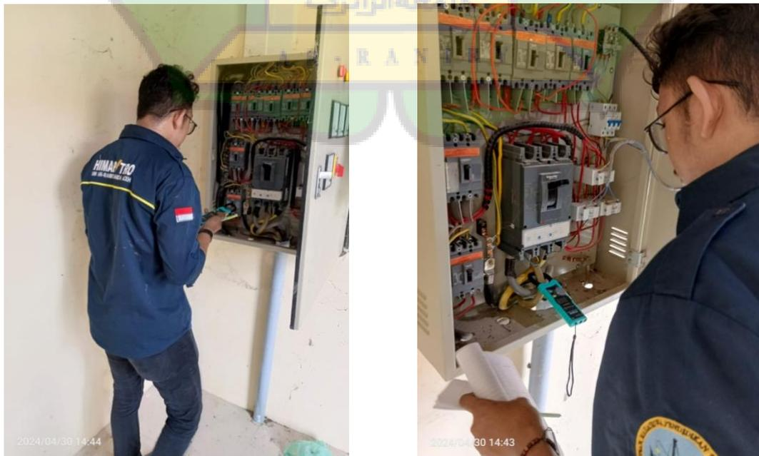
2. Pengukuran arus dan tegangan pada panel MDP
