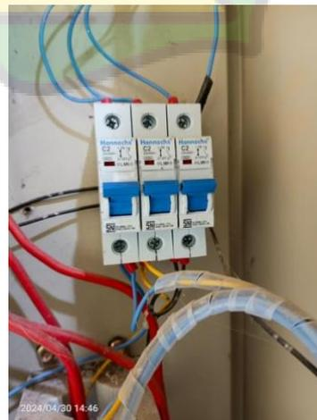
(e) MCCB 30 A penerangan luar gedung (f) MCB volt meter di panel
