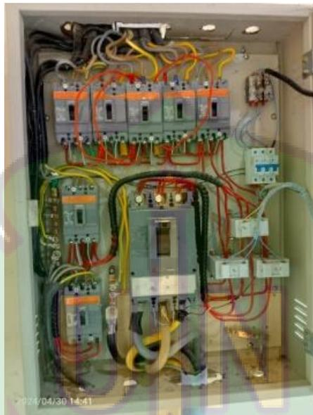
gambar 4.3 Warna kabel pada panel MDP
