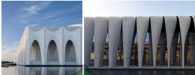
Gambar 4. 12 penerapan Secondary Skin pada Bangunan (Sumber: Pinterets.com, 2023)
