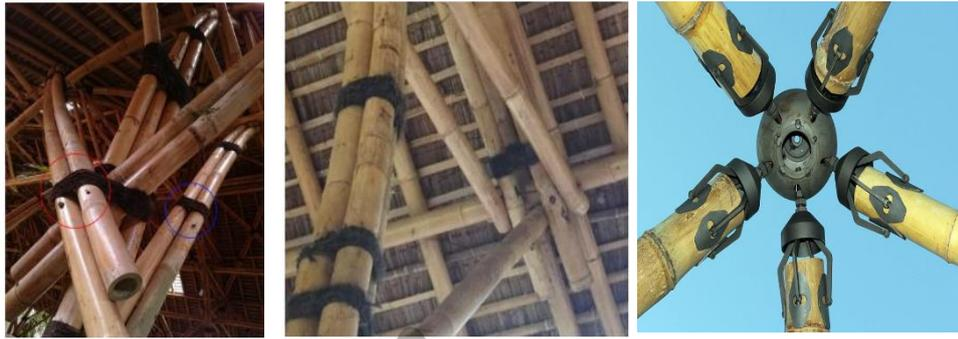
Gambar 5.16 Penggunaan Bracing dan Sambungan pada Struktur Atas
