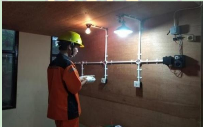
Gambar 2.1 Pemasangan Instalasi Listrik
