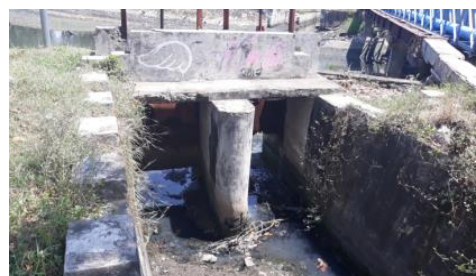
Gambar 18.4 Pintu Air Drainase Sumber : Dokumentasi Pribadi
