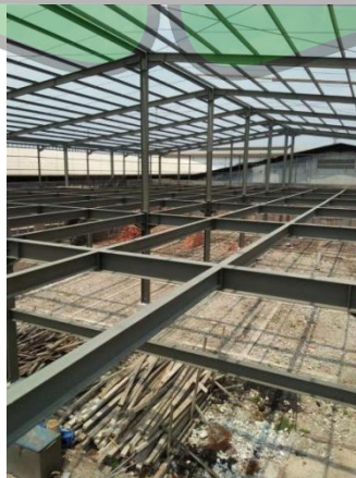
Gambar 12.1 Konstruksi Baja Sumber : Google Image
