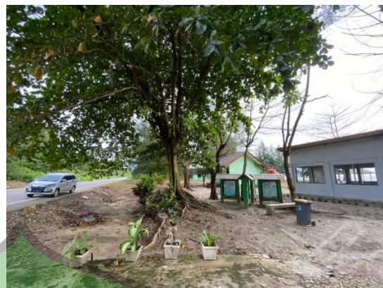
Gambar : Lingkungan Kantor Stasiun
