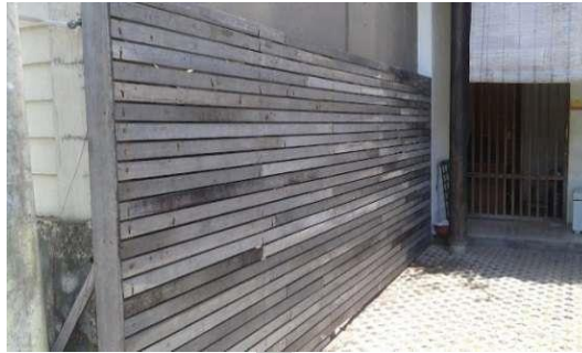
Gambar 4. 60 Dinding Kayu Sumber: www.arsitur.com/
