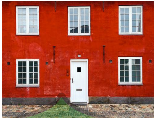
Gambar 2.1 Komponen Fasad Jendela dan pintu masuk ke bangunan
