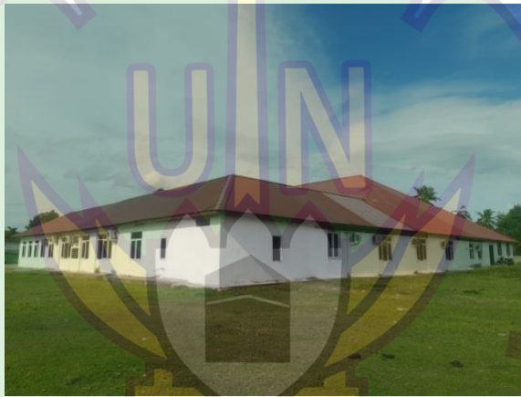
Dokumentasi gedung Pondok Pesantren Tahfiz Sulaimaniyah habibi Center
