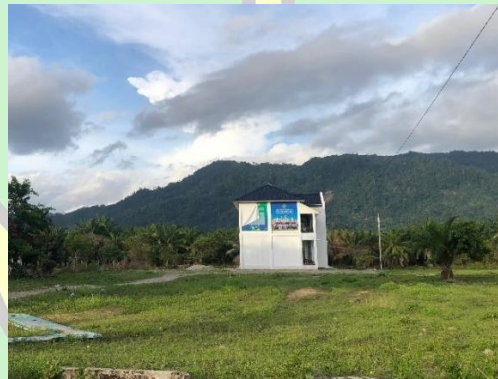
Gambar 4 9 STAI Aceh Selatan
