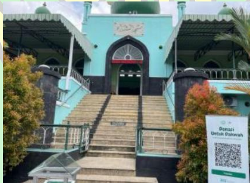
Gambar 3 13 Akses Entrence Masjid Syuhada
