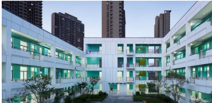
Gambar 3. 2.Fasad dalam Bangunan School Nanjing, China
