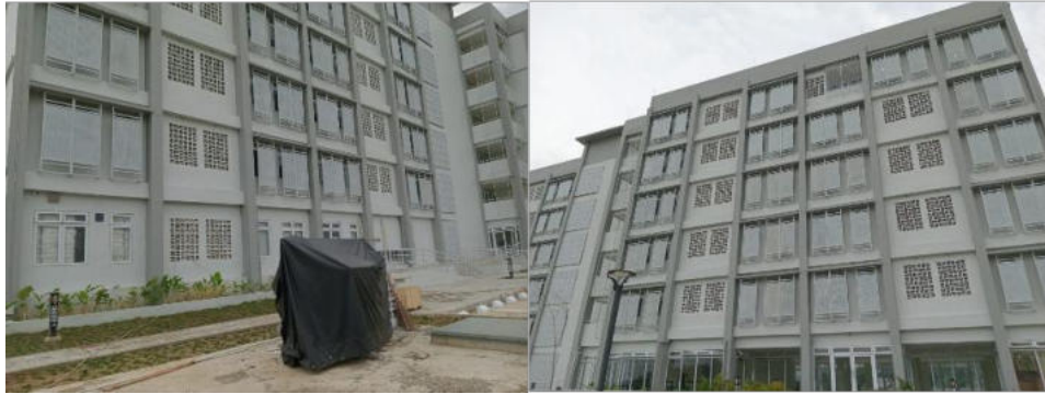
Gambar 2.4 Kondisi area Rumah Susun ASN PUPR Aceh Besar
