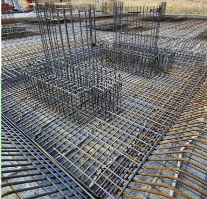
Gambar 4. 36 Pondasi rakit/ raft
