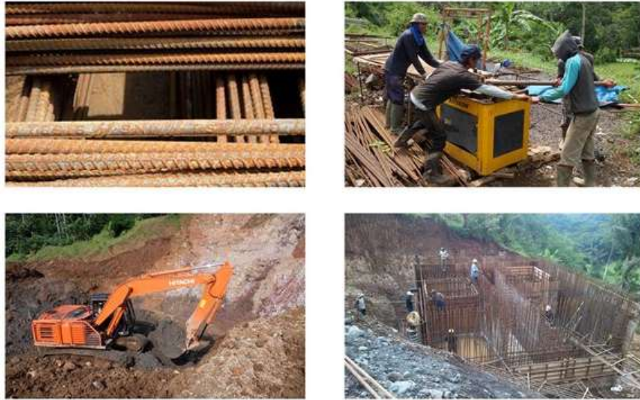
Gambar 4. 37 Pondasi Caisson
