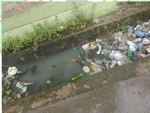
Gambar 1.1 Kondisi saluran drainase hasil observasi awal
