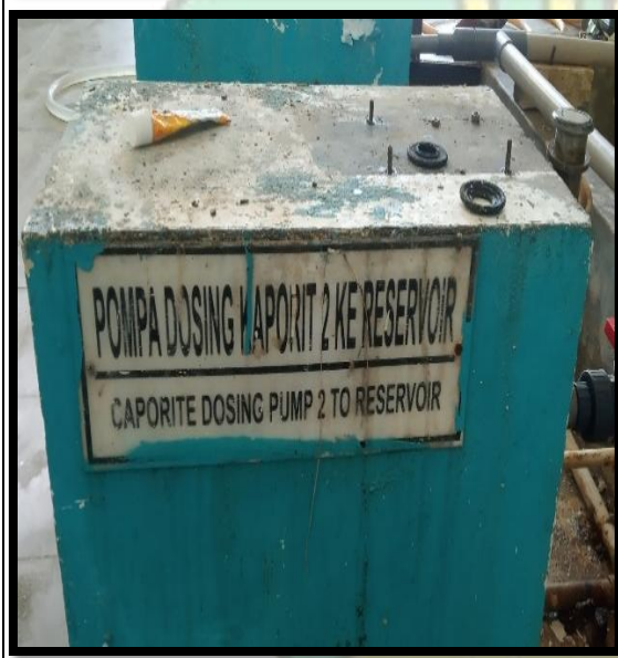
Tempat Pembubuhan Dosis Disinfektan
