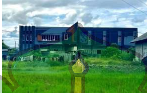
Gambar 5. Situasi lingkungan di sekitar Perusahaan Bintang Prima Perkasa
