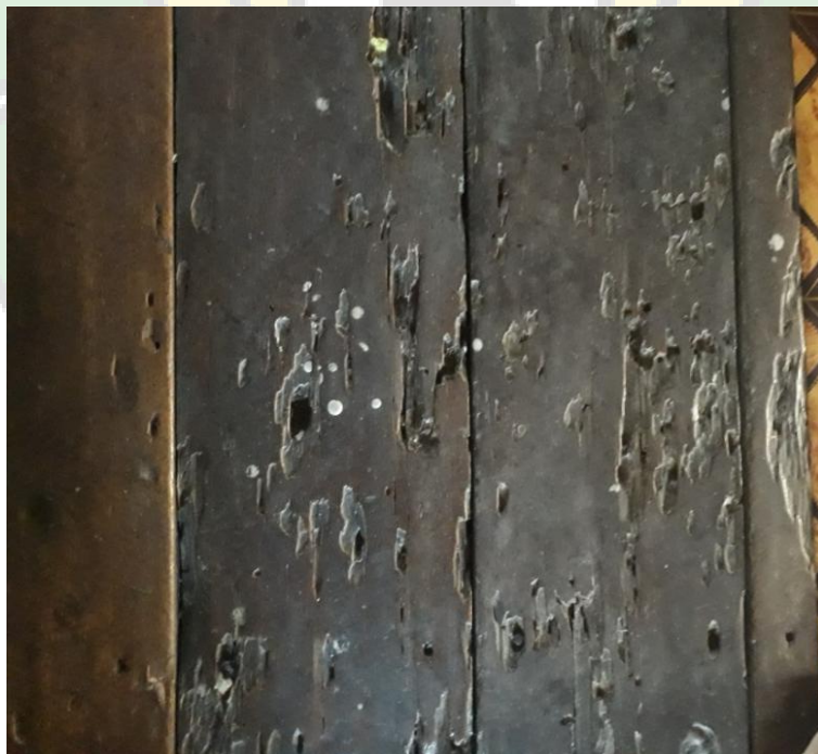
Kondisi lantai di dalam bangunan tua yang sudah dimakan rayap (dok. Penulis)
