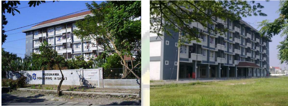
Gambar 2.38 Gedung Rusunawa Penjaringan Sari 3 Sumber: http://digilib.uinsby.ac.id , 2017
