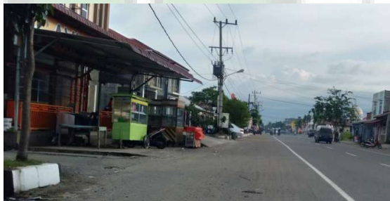
Gambar 4.7 Sumber Jaringan Listrik Sumber: Dokumen Pribadi, 2018
