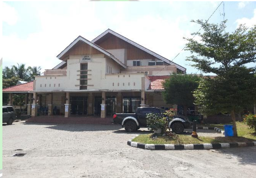
Gambar 2.25 : Kondisi Eksisting Aula Jeddah Sumber : Dokumentasi pribadi
