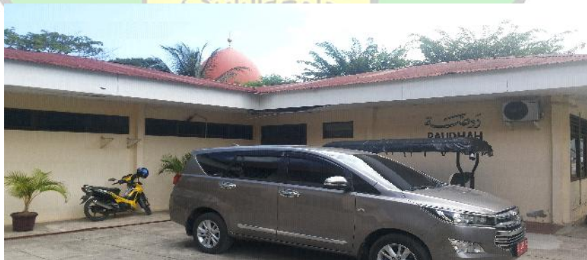
Gambar 2.19 : Kondisi Eksisting Gedung Raudhah Sumber : Dokumentasi pribadi
