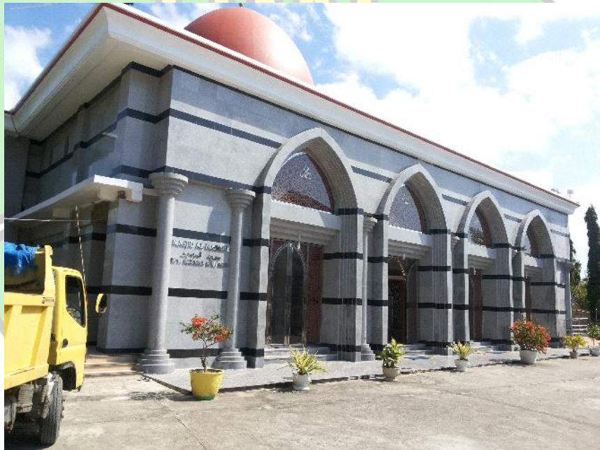
Gambar 2.22 : Kondisi Eksisting Masjid Sumber : Dokumentasi pribadi
