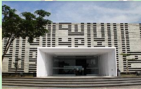
Gambar 3.9 : Material Bangunan Masjid Al irsyad bandung Sumber : Googlemaps.com
