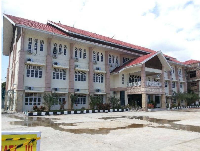
Gambar 2.18 : Kondisi Eksisting Asrama Madinatul Hujjah Sumber : Dokumentasi pribadi
