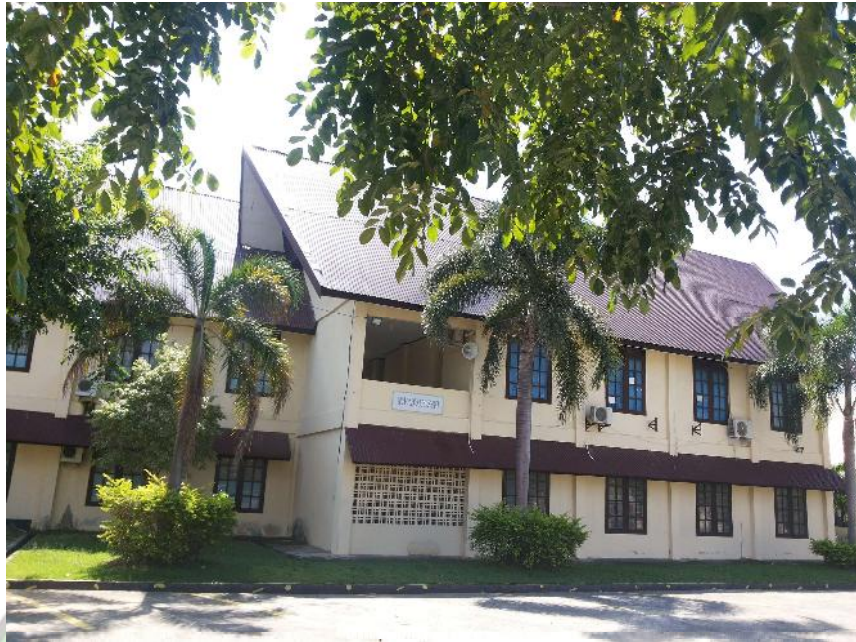
Gambar 2.16 : Kondisi Eksisting Asrama Madinah Sumber : Dokumentasi pribadi
