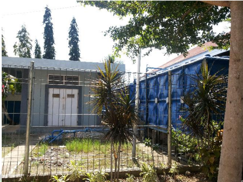
Gambar 2.26 : Kondisi Eksisting Ruang M.E disamping gedung arafah Sumber : Dokumentasi pribadi
