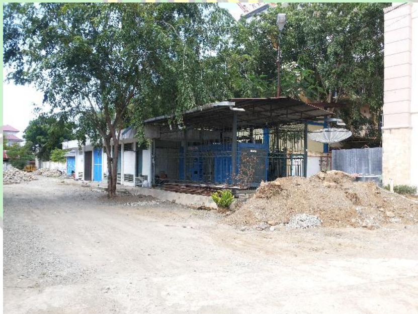
Gambar 2.27 : Kondisi Eksisting Ruang M.E disamping gedung misfalah Sumber : Dokumentasi pribadi
