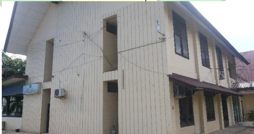
Gambar 2.21 : Kondisi Eksisting Gedung Makkah Sumber : Dokumentasi pribadi
