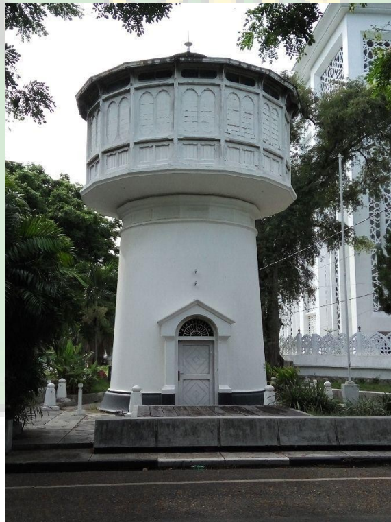
Gambar 2: Menara Air ( Water Torren ) Sumber: Aisarah Rahmadhana
