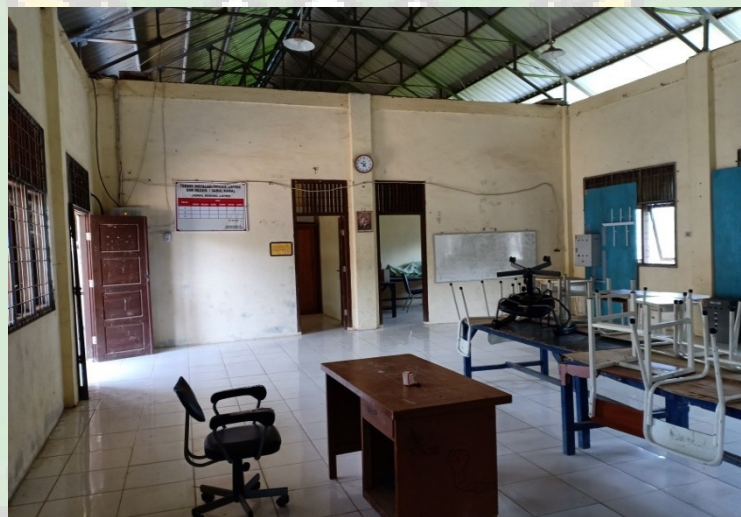
Gambar 6 Kondisi Ruangan lab Listrik
