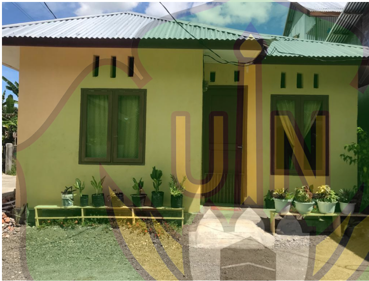
Gambar 4.2 kondisi dalam rumah
