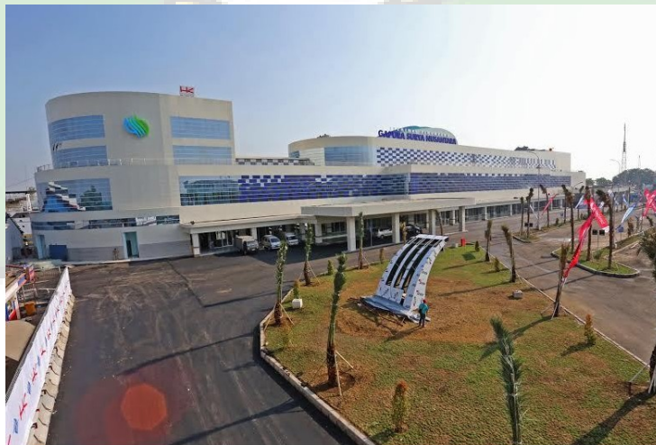
Gambar 2.2 Terminal Gapura Suya Nusantara (Sumber : jurnalmu.wordpress.com )
