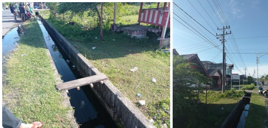
Gambar 4.8 Kondisi Eksisting Utilitas
