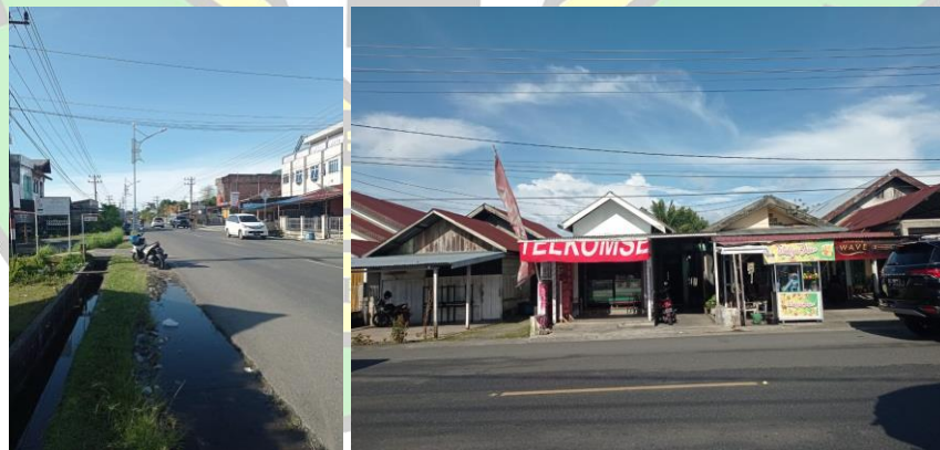
Gambar 4.7 Kondisi Jalan Imam Bonjol
