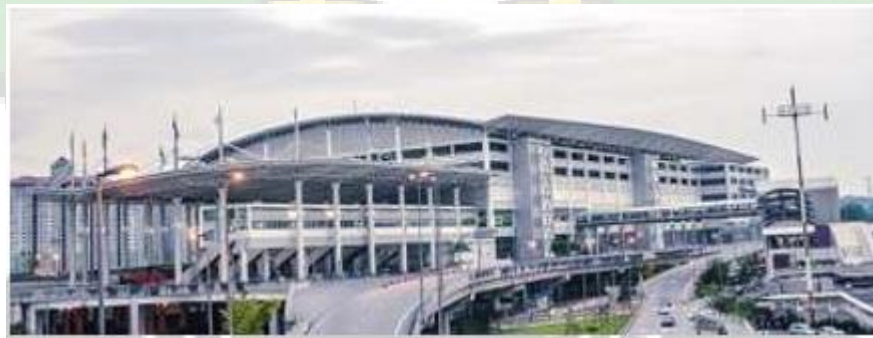
Gambar 2.15 Terminal Bersepadu Selatan – Malaysia
