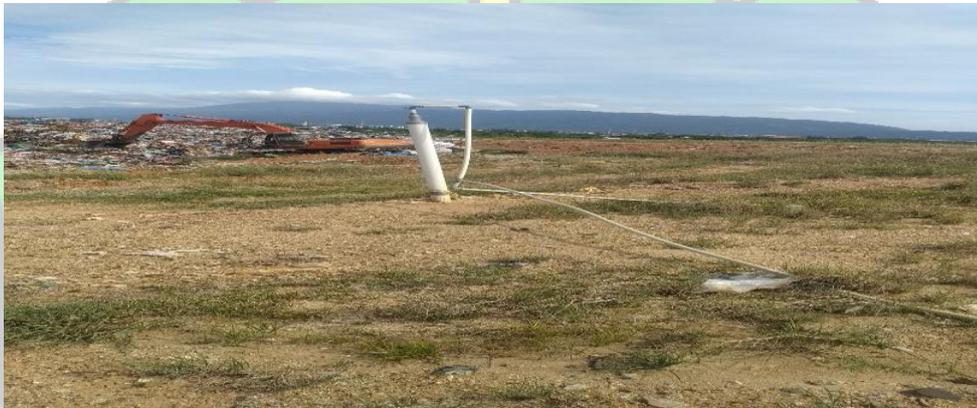
Foto pipa vertikal dan horizontal untuk menangkap dan mengaliri gas metan
