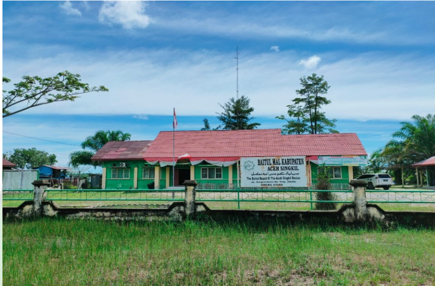
Gambar 1.1. Kantor Baitul Mal Kabupaten Aceh Singkil
