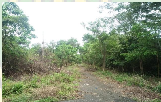
Gambar 1. 2 Kondisi Eksisting Jalan
