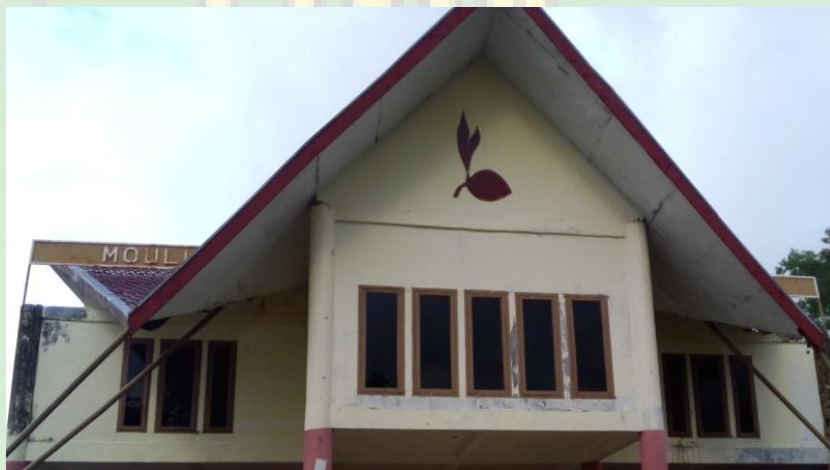
Gambar 2.24 kondisi bangunan meuligo bupati Pramuka
