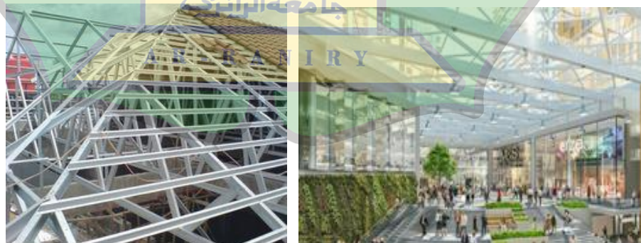
Gambar 5.17 : Struktur atap pada bangunan utama dan retail
