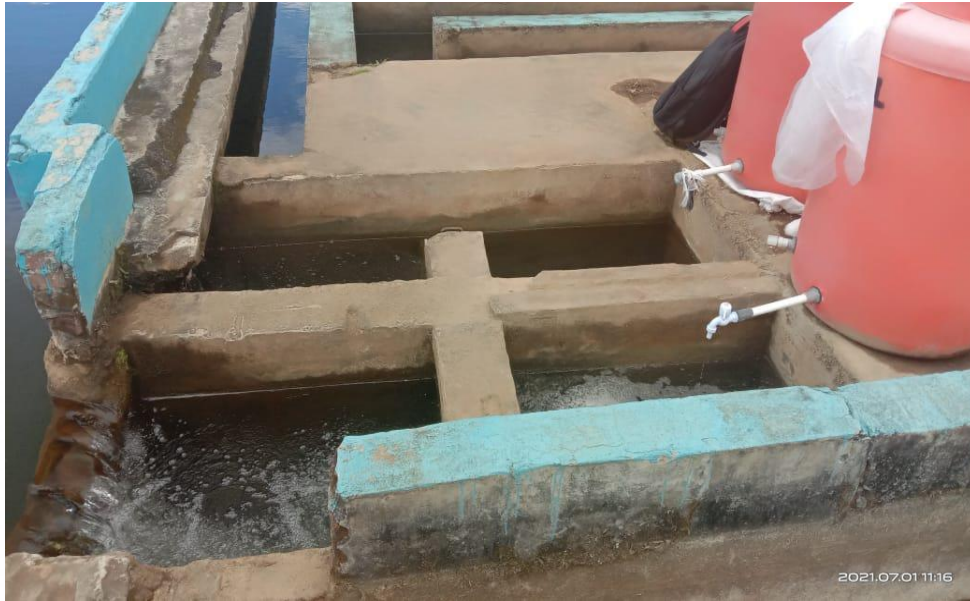
Gambar 4.5. Unit Pembubuhan Koagulasi IPA Lelabu
