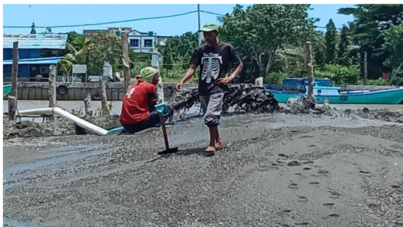
Proses penumpukan pasir menggunakan sedotan mesin
