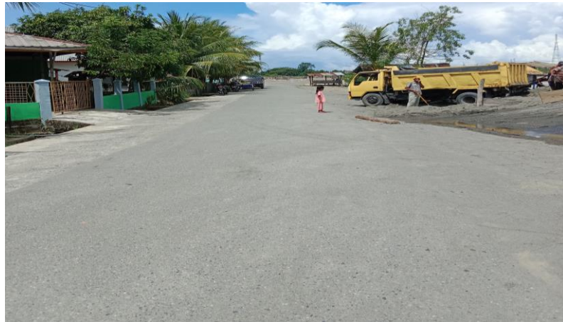
Ini adalah kondisi jalan yang baru diperbaiki, jalan tersebut merupakan jalan yang dilewati mobil dumtruck penambangan.
