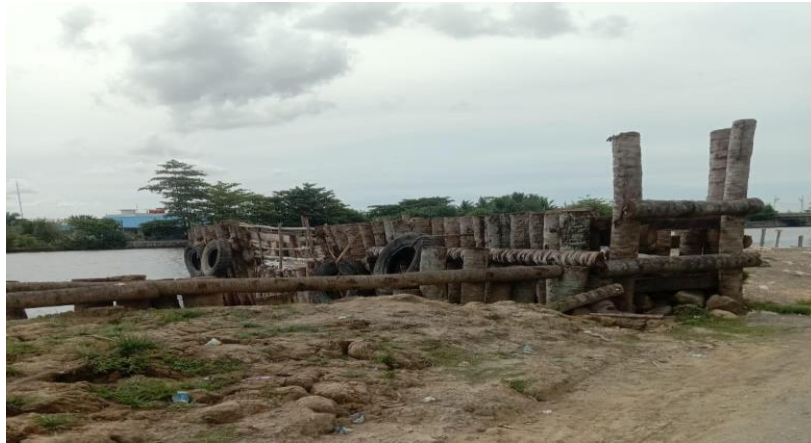
Ini adalah satu lahan yang rusak akibat dari penumpukan pasir dipinggiran sungai, sehingga pekerja tambang membuat tanggul seperti yang ada dalam gambar tersebut.
