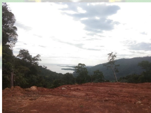
Gambar 3.4 Kondisi Eksisting 1 Sumber: Dokumen Pribadi
