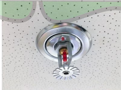
Gambar 5.22 : sprinkle (Sumber : https://steadfastfire.com , diakses pada tanggal 4 November 2020)
