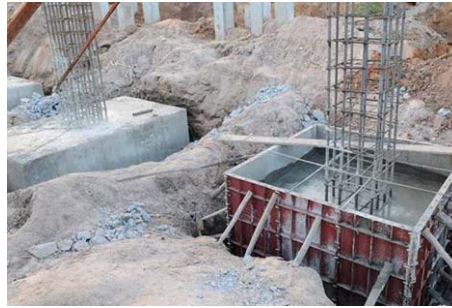
Gambar 5.15 : Pondasi Tapak (Sumber : www.transrumah.com , diakses pada tanggal 3 juli 2022)
