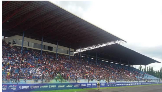
Gambar 2.10 : Bangunan Tribun Pada Sirkuit Sentul (Sumber : https://sports.okezone.com , diakses pada tanggal 27 Juli 2020)
