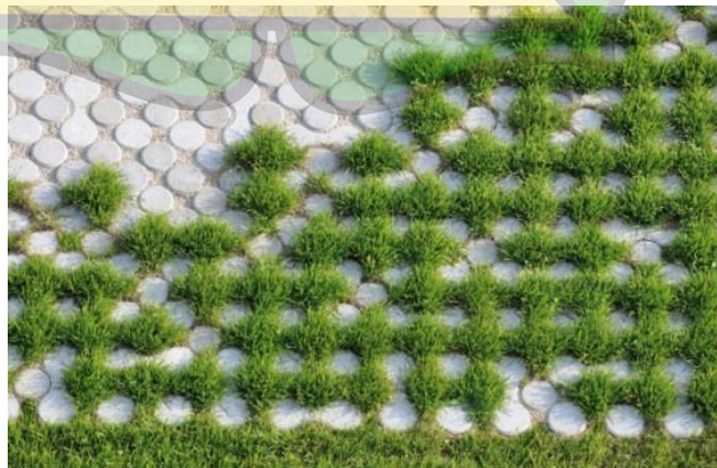
Gambar 4.15. penggunaan grasscrete sebagai material perkerasan
