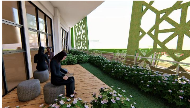
Gambar 5.9 : Secondary Skin untuk Pembayangan (Sumber : Analisis Pribadi, 2021)
