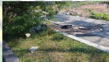
Gambar 4.9 : Saluran Drainase Kota (Sumber : Dokumentasi Pribadi, 2019)
